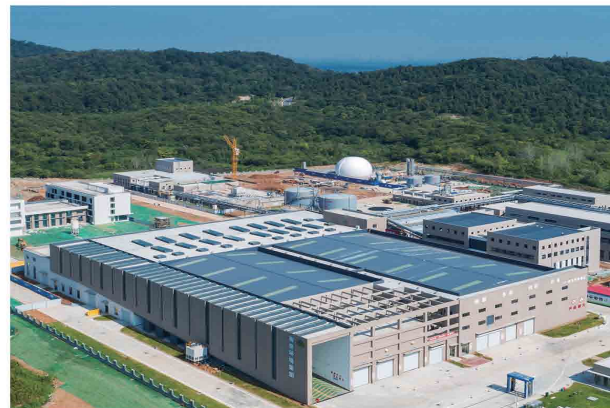
南京江北废弃物综合处置中心工程，国内第一个工艺系统齐全、技术先进、资源化程度高的餐厨垃圾处理项目
