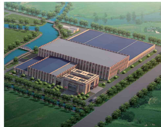
上海松江建筑垃圾资源化利用工程，年处理规模60万吨
