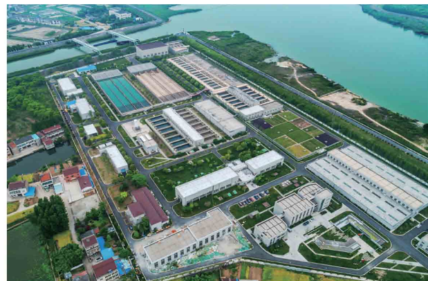
常州魏村水厂日供水处理规模70万吨，生活用水提高为“优质水”
