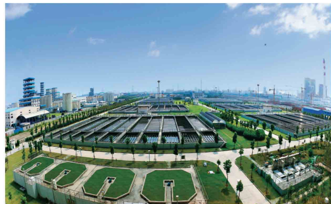
上海白龙港污水处理厂，日处理污水能力280万吨，亚洲最大的污水处理厂，荣获国家优质工程金奖和中国市政金杯示范工程
